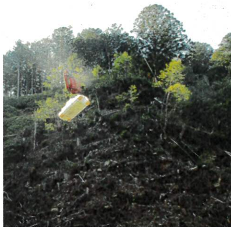
架線を利用した資機材運搬
