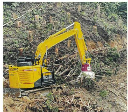
クラッシャーを装着したバックホー
