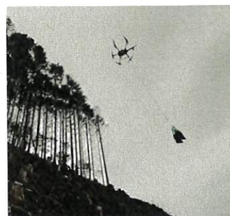
ドローンによる資機材運搬
