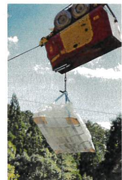
資機材の吊り下げ
